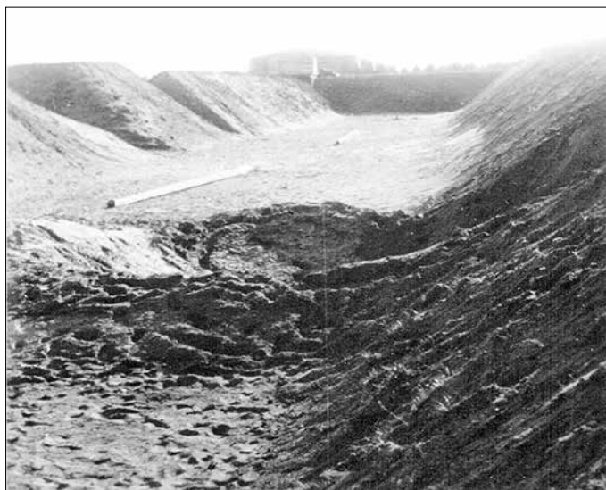
Skutki nalotu z 26/27 października 1940 roku na Hydrierwerke. W głębi instalacje fabryczne.
