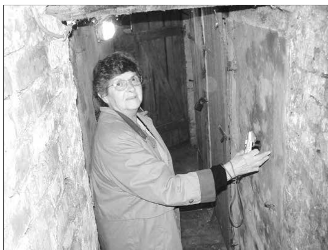
W tej samej piwnicy, w roku 2003
