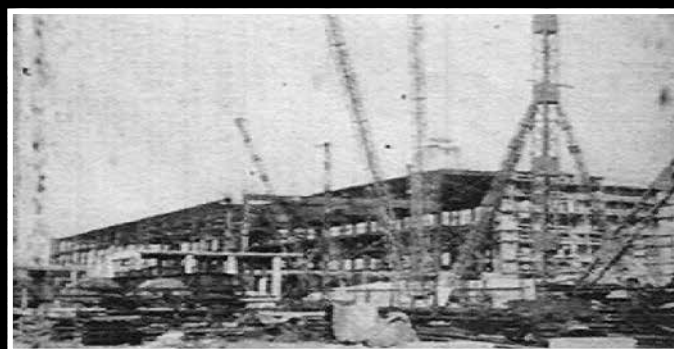
Ryc. 24. Elektrownia w budowie, 1939 r. Źródło: http://www.youtube.com/watch?v=MS6cK2daUI
