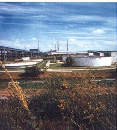
Od lipca 1998 r. zakładowa oczyszczalnia rozpoczęła utylizowanie także ścieków komunalnych z miasta Police
