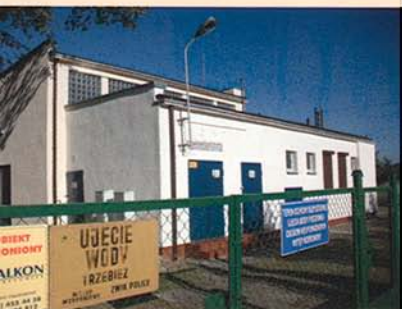
Stacja uzdatniania wody w Trzebieży
