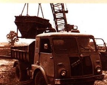
Transport płynnego betonu przeznaczanego na konstrukcje, 1967 r.
