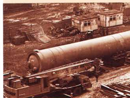
Rozpoczyna się drugi etap budowy ZCh „Police”, 1979 r.
