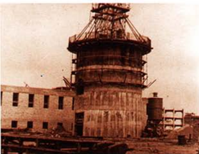
Powstają konstrukcje wytwórni bieli tytanowej, 1976 r.
