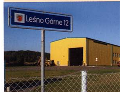
Zakład Odzysku i Składowania Odpadów Komunalnych w Leśnie Górnym
