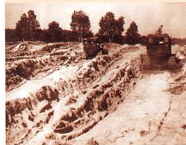
Pierwsze spychacze na budowie, 1964 r.
