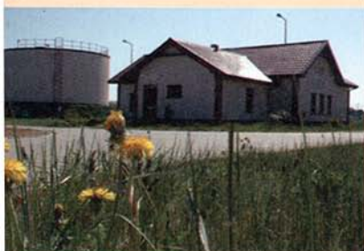
Stacja uzdatniania wody w Tanowie
