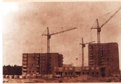
Osiedle „Chemik” w budowie, 1979 r.
