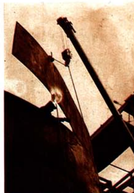
Monterzy „Mostostalu” przy pracy, 1967 r.
