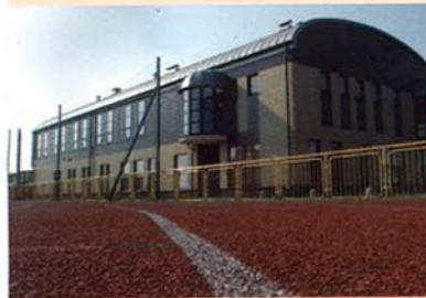
Kompleks rekreacyjno-sportowy przy ul. Piaskowej w Policach
