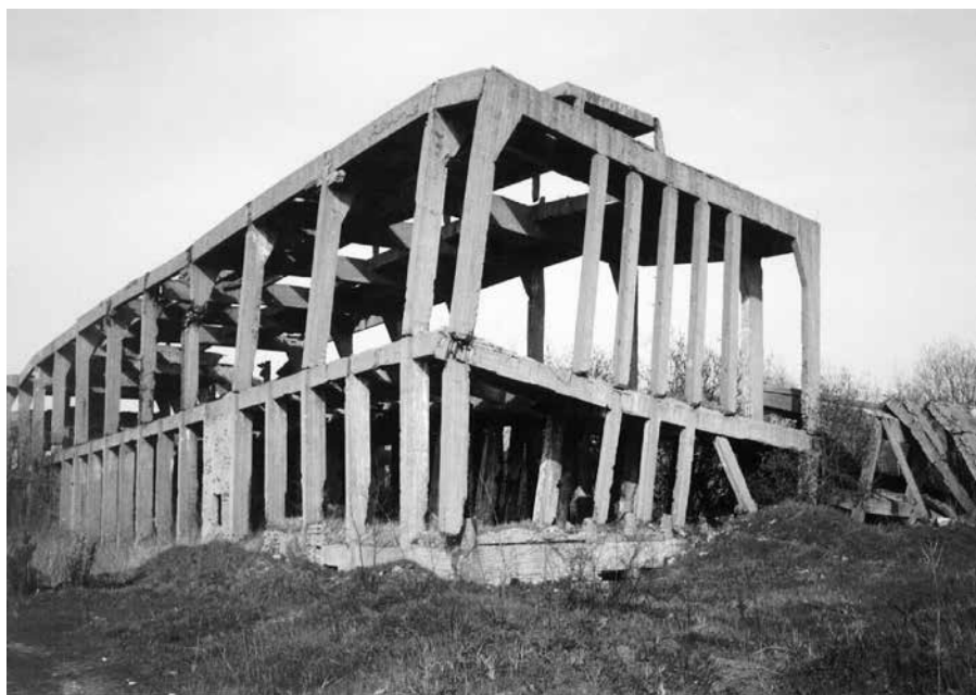
Zbombardowana hala produkcyjna Hydrierwerke
