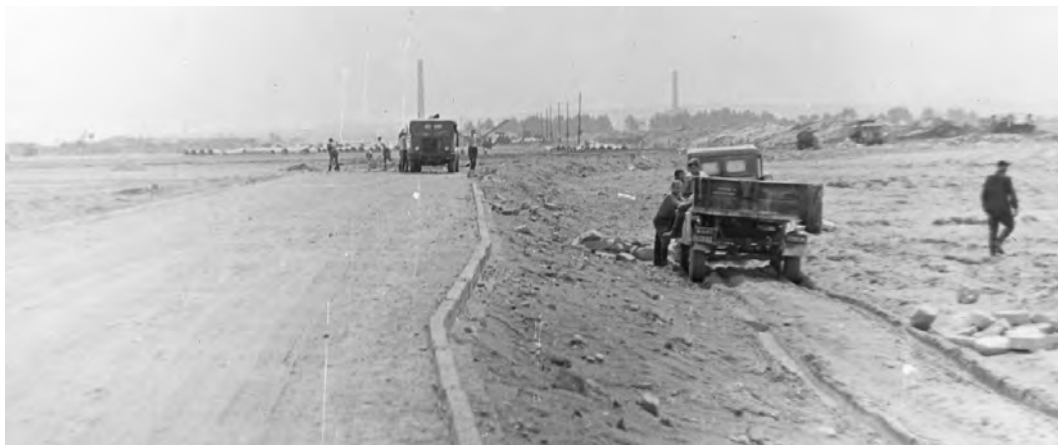
Powstaje droga dojazdowa na budowę od strony Trzeszczyna, 1966 r.
