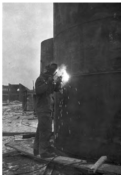
Przy budowie Zakładu Fosforowego
