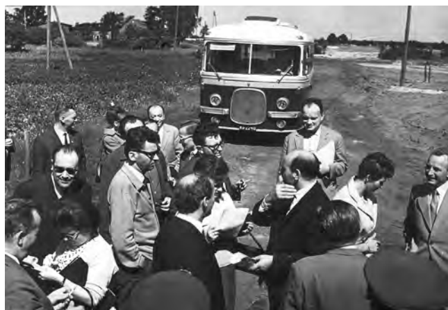
Przedstawiciele generalnego wykonawcy oprowadzają po terenie przyszłej budowy projektantów z biura „Biprokwas”, Gliwice 1966 r.
