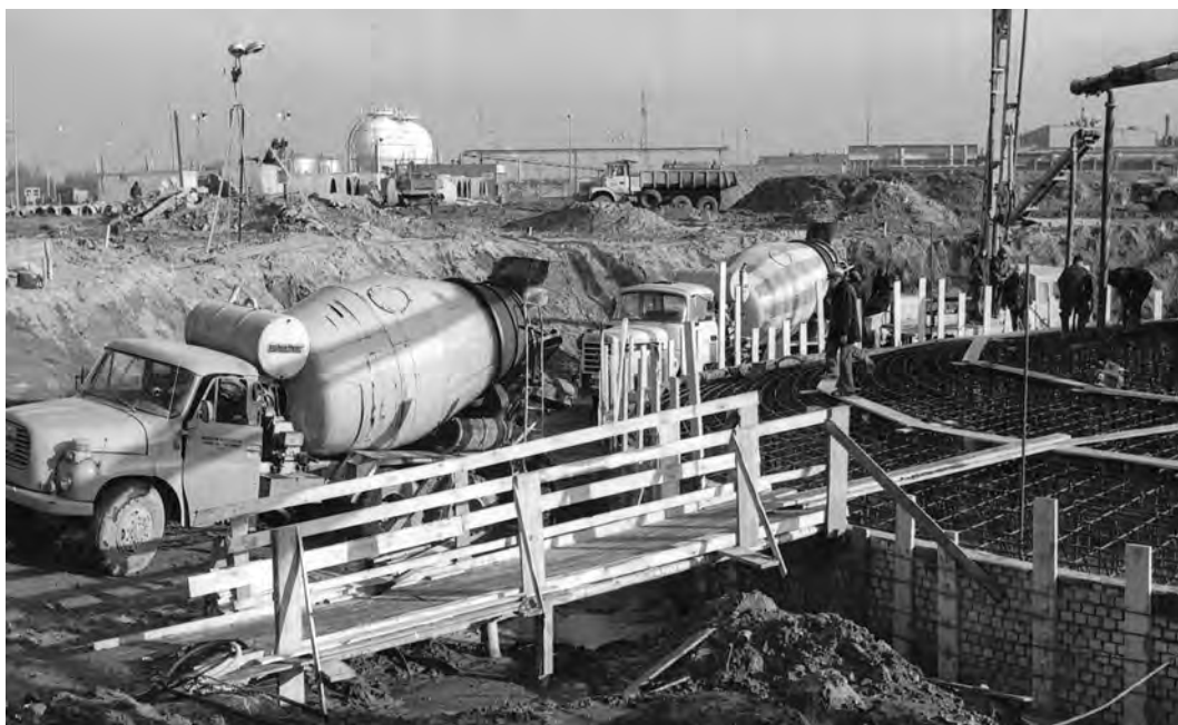
Na budowie Z.Ch. „POLICE”
