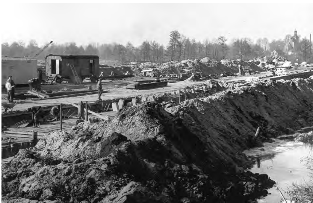
Budowa kanału Gunica dla transportu materiałów do budowy Polic
