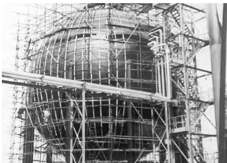
Budowa instalacji Zakładu Amoniak, 1970 r.
