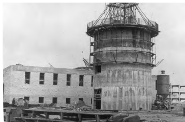
Powstają kolejne obiekty Zakładu Bieli Tytanowej, 1976 r.
