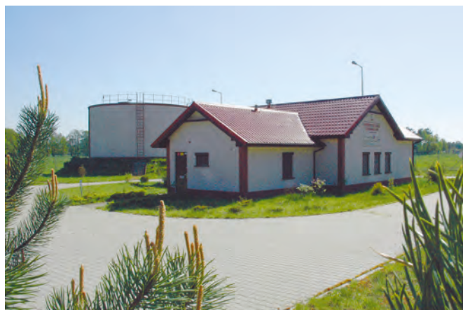
Stacja uzdatniania wody w Tanowie
