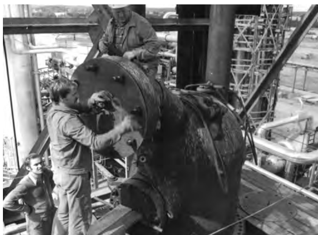
Budowa Z.Ch. „POLICE”
