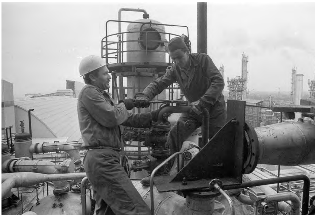
Budowa wydziału NPK, początek lat siedemdziesiątych
