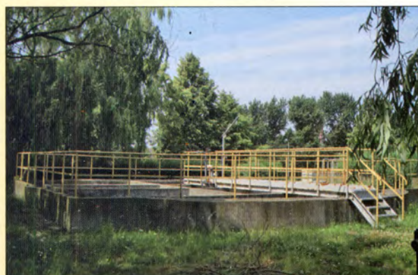
Od 1909 r. do 1998 r. przy ul. Dębowej funkcjonowała oczyszczalnia ścieków, po wybudowaniu rurociągu tłoczego ścieki są kierowane do oczyszczalni Zakładów Chemicznych „Police” S.A. Przy ul. Dębowej istnieją przedwojenne i powojenne zbiorniki do oczyszczania ścieków (obecnie pełnią funkcję zbiorników rezerwowych wykorzystywanych w przypadku awarii rurociągu).
