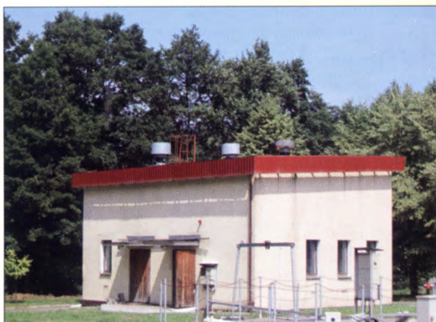
Budynek przepompowni i jego wnętrze
